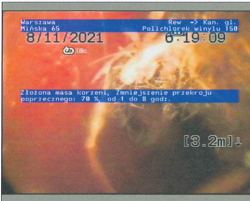
Zdjęcie: 1_1_4_15082021_114729_A.JPG 3,2m, Złożona masa korzeni, Zmniejszenie przekroju poprzecznego: 70 %, od 1 do 8 godz.
