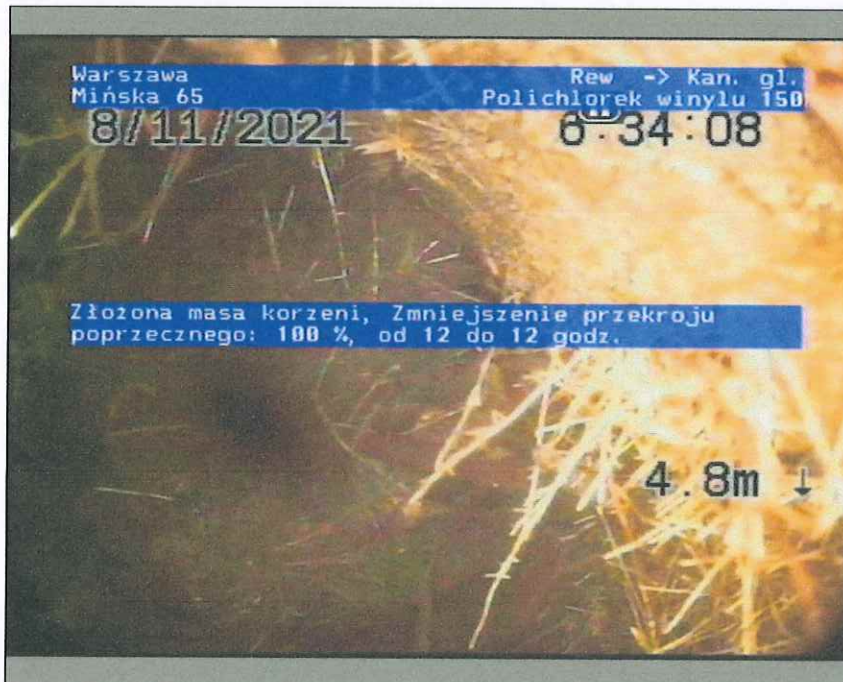
Zdjęcie: 1_1_6_15082021_115343_A.JPG 4,9m, Złożona masa korzeni, Zmniejszenie przekroju poprzecznego: 100 %, od 12 do 12 godz.
