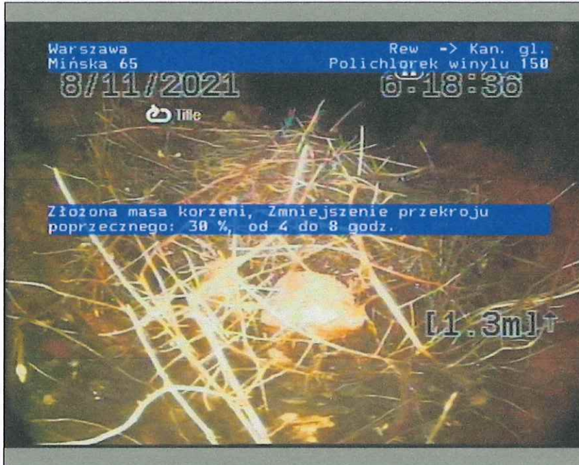
Zdjęcie: 1_1_3_15082021_114631_A.JPG 1,2m, Złożona masa korzeni, Zmniejszenie przekroju poprzecznego: 30 %, od 4 do 8 godz.
